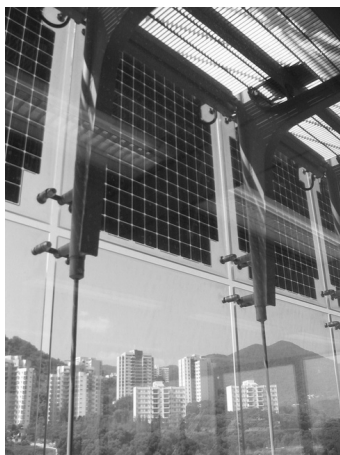
Slika 3 – Kombinacija dvostruke fasade i fotonaponskih panela na objektu Hong Kong Science Museum
