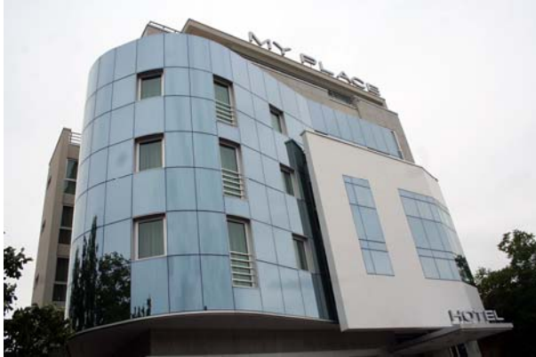
Slika 7 – Erkeri na uličnoj fasadi
