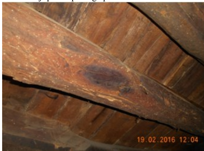
Slika 3 –Međuspratna greda sa slikom tipičnih oštećenja izazvanih dejstvom insekata, lošom preventivnom zaštitom i selekcijom materijala
