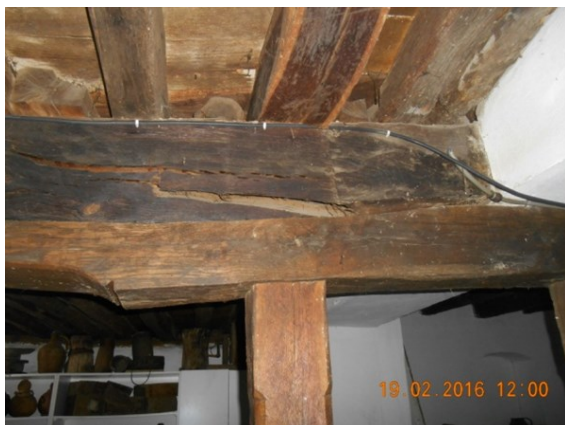
Slika 4 – Oštećenja centralne, noseće grede MSK
