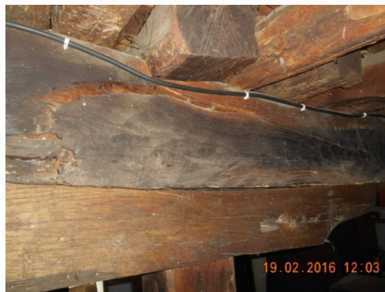
Slika 4 – Oštećenja centralne, noseće grede MSK
