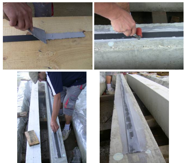
Slika 3: Postupak postavljanja FRP laminata (Niš, 2009.)
