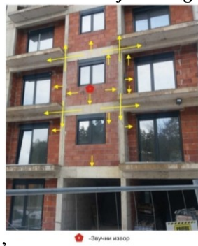
Slika 6 – Objekti u izgradnji (dokumentacija autora)
