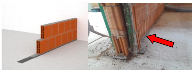
Slika 18 - Isolmant ispod zida [9]
