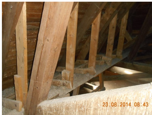
Slika 5. Zakrivljeni nosači sa podupiračima na dvorišnoj strani kupole.
