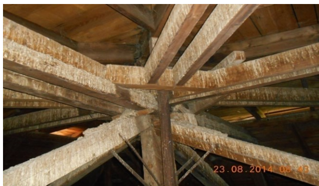
Slika 4. Veza konstrukcijskih elemenata-složeni zglob.
