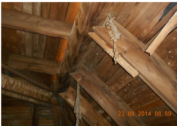
Slika 7. Veza između vrhova ZN i okvirne grede u vrhu kupole, sa jasno izraženim zazorom.
