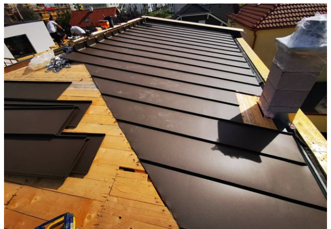
Slika 8 – Tok izgradnje kuće
