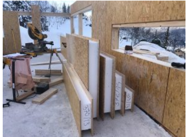
Slika 10 – SIP paneli za gradnju kuće [10]
