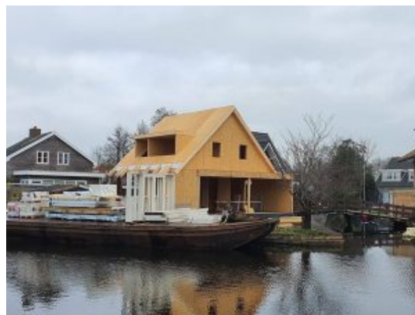
Slika 4 – Kuća tokom izgradnje [9]
