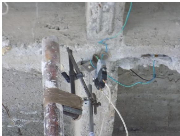
Slika 3 – Položaj LVDT – ugibomera u L/2 (U1) i merne trake na armaturi (MT1)
