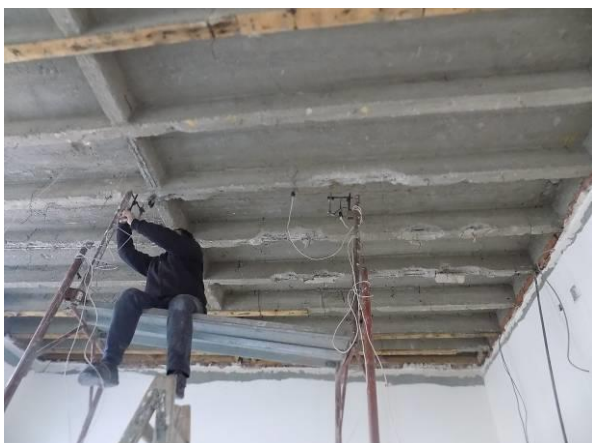
Slika 1 – Priprema mernih mesta na međuspratnoj konstrukciji – donja strana
