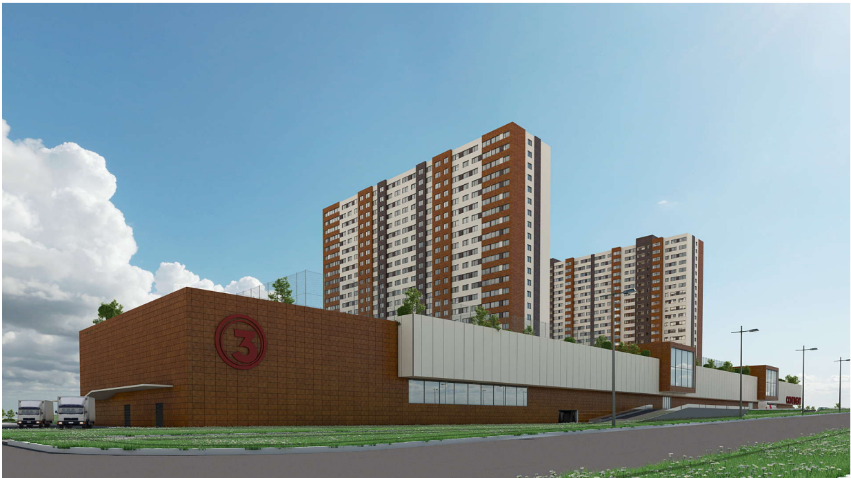
Slika 3 .Izgled objekta sa glavne saobraćajnice.
