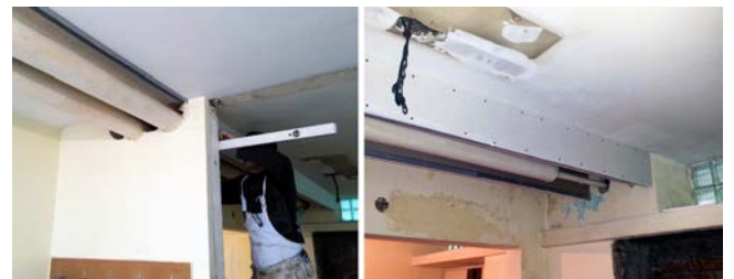
Slika 6 – Gradjevinski i zanatski radovi
