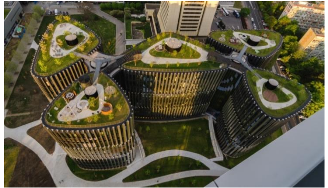
Slika 8 – Poslovni objekat, Prag - Intenzivni zeleni krovovi kao peta fasada objekta projektovani su kao vrtovi kako bi korisnicima bila omogućena veza sa otvorenim prostorom.
