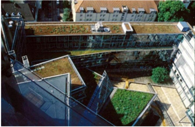
Slika 3 - North German Bank – NordLB (Behnisch, Behnisch & Partner), Hanover – Poslovna zagrada sa 13 ekstenzivnih i 2 intenzivna krova ukupne površine od 5000m 2 čime je uspostavljena intenzivna veza između unutrašnjeg prostora i spoljašnosti.
