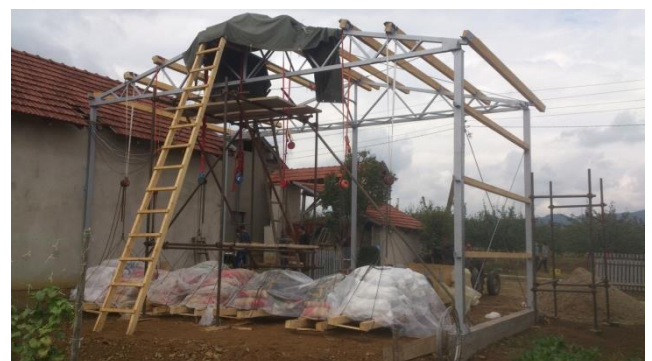
Slika2 – Aplikiranje realnog opterećenja – in situ [6]
