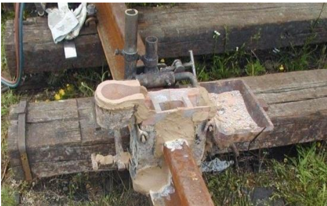
Slika 12 - Postavljanje kalupa na mesto spoja
