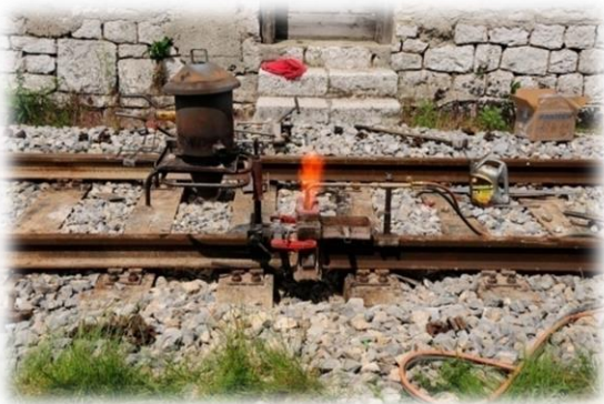
Slika 16 - Aluminotremijska reakcija u loncu
