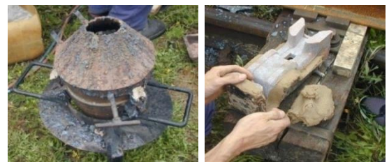
Slika 4 - Lonac za aluminotermijsko zavarivanje. Slika 5 - Postupak nanošenja višeputnu upotrebu gline na kalup
