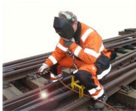
Slika 27 - Prikazan je postupak elektrolučnog zavarivanja
