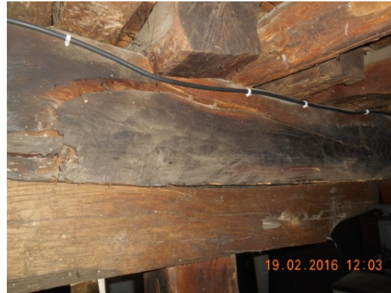
Slika 4 – Oštećenja centralne, noseće grede MSK
