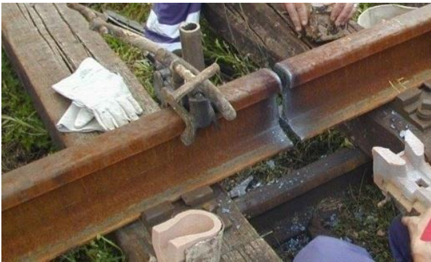
Slika 11- Priprema spoja i položaj šine pre zavarivanja
