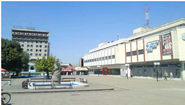
Slika 2 – Trg u Pirotu pre rekonstrukcije
