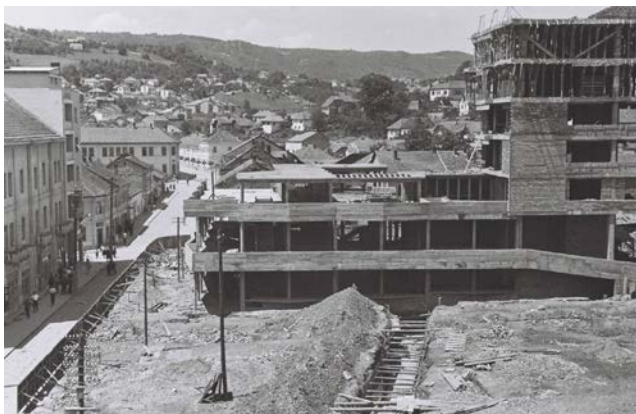
Slika 03. Robna kuća „Progres“, tokom izgradnje, istočni izgled (1960)
