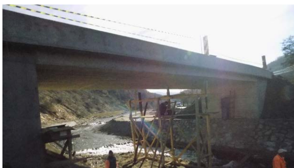
Slika 3: Izgled mosta (nizvodna strana)
