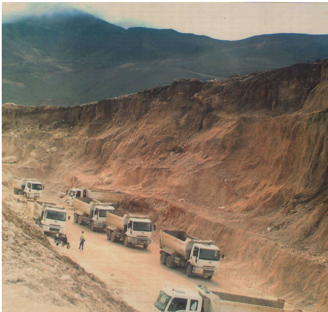
Slika 2. Široki iskop na lokaciji budućeg tunela
