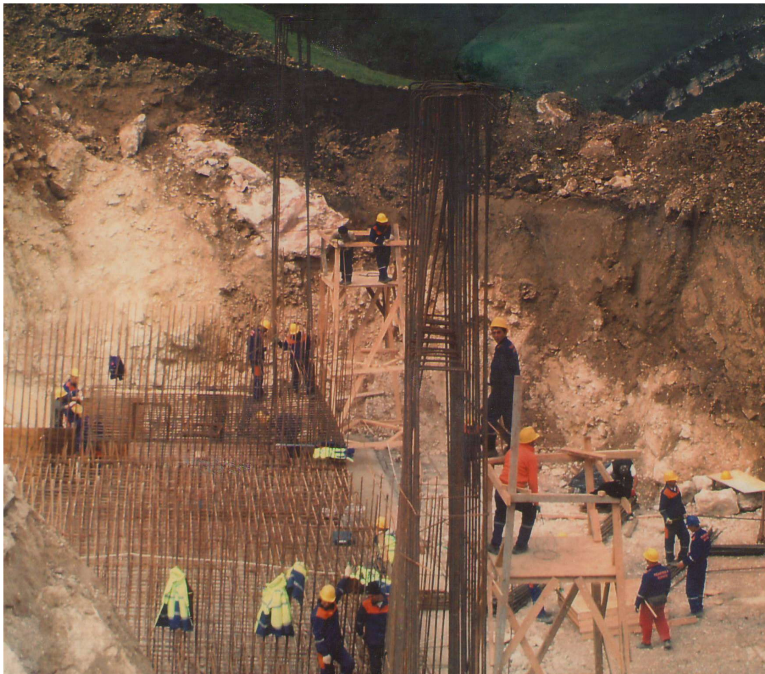
Slika 22. Fotografija sa gradilišta – armirački radovi na donjoj ploči i potpornim zidovima ulaznog dela tunela
