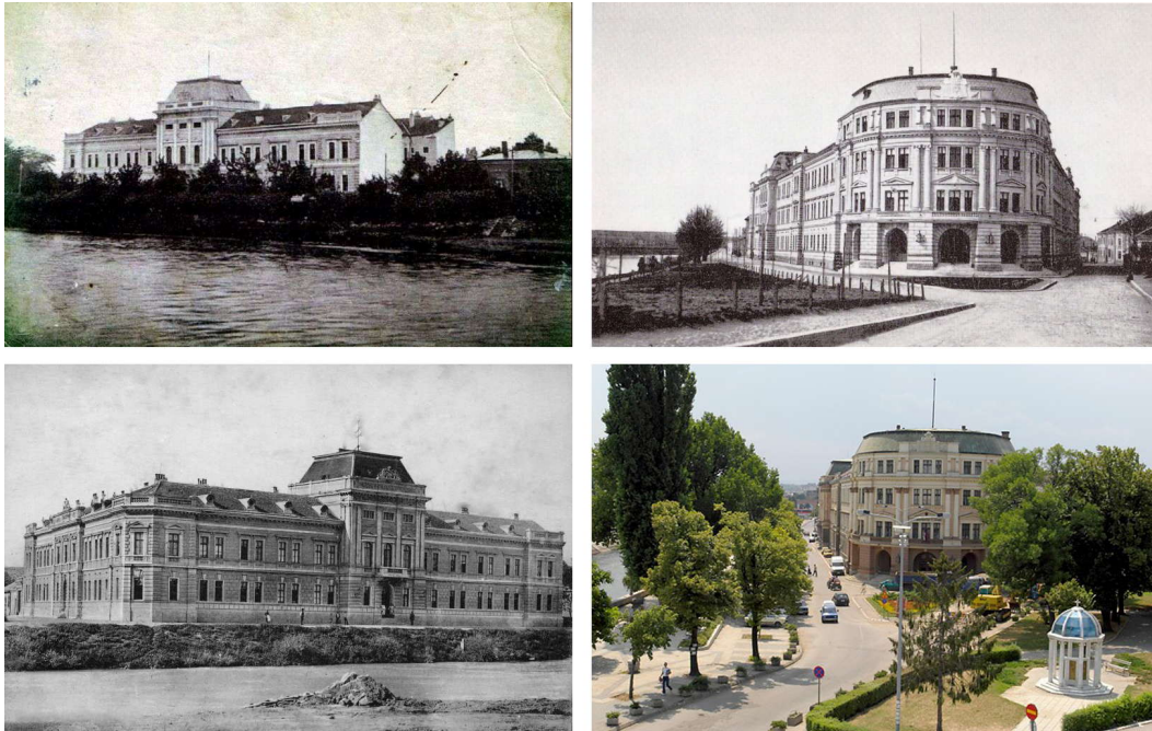
Slika 1 – Zgrada Banovine u različitim fazama
