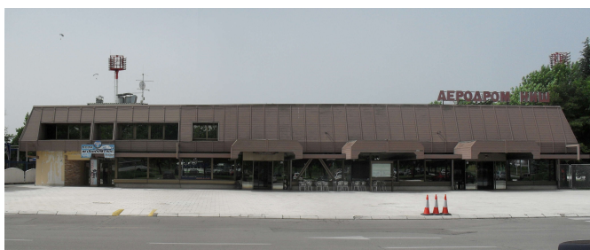
Slika 2 – Trenutni izgled severne fasade objekta
