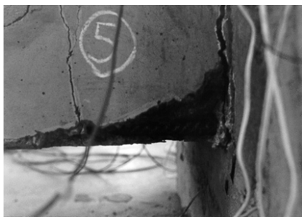
Slika 11 – Model EM-5: Prikaz pukotina u modelu i dela slomljenog zaštitnog sloja
