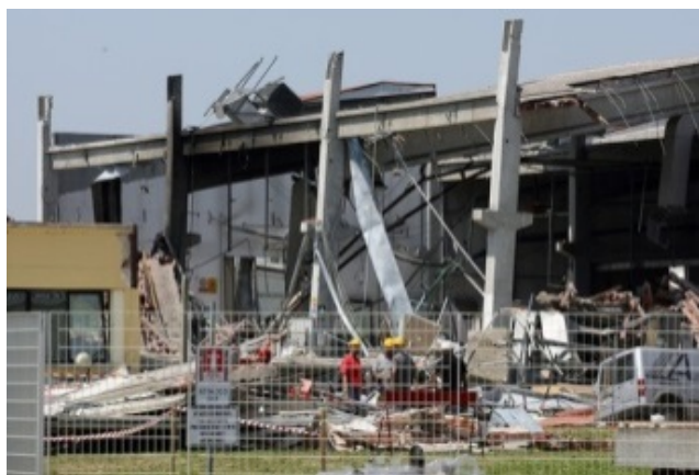
Slika 1 – Karakteristični primeri oštećenja i rušenja za vreme zemljotresa u severnoj Italiji 2012. ( https://www.republicain-lorrain.fr/fil-info/2012/05/29/italie-un-nouveau-seisme-dans-le-nord-est-fait-au-moins-dix-morts )
